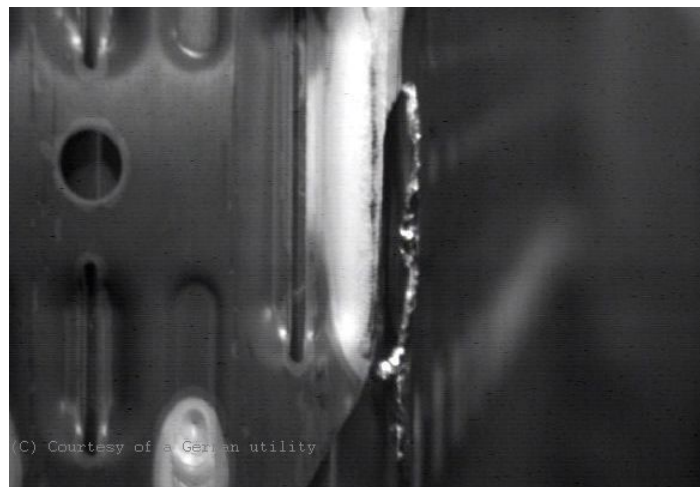
Abb. 6: Eckenschaden an einem Abstandhalter aufgrund von Reibkorrosion /U 25/
