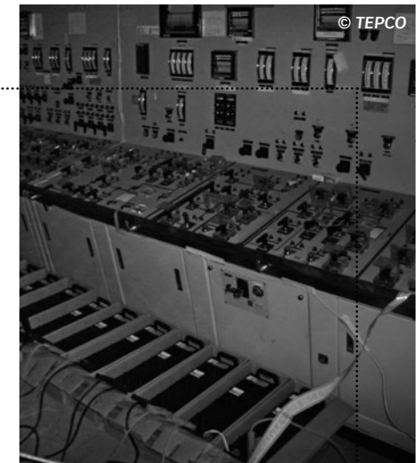
Versorgung von Warteninstrumenten mittels Autobatterien (Aufnahme vom 22.03.2011)
