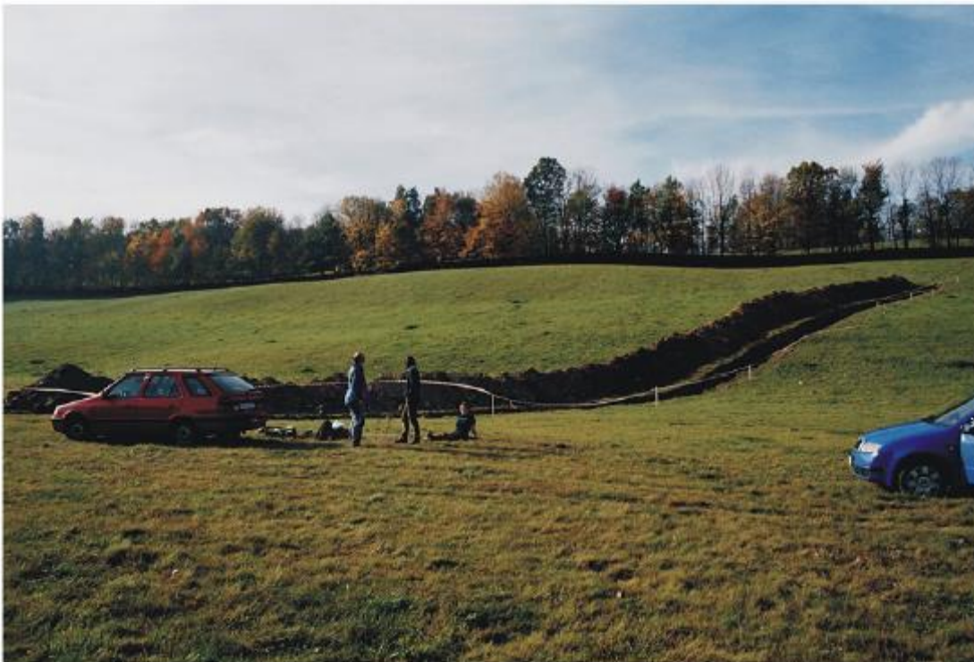
Abbildung 38: Ein angelegter Schurf im tektonisch aktiven Bereich [Štěpančíková et al. 2010].
