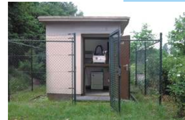
Radiologische Messstation des KKE
